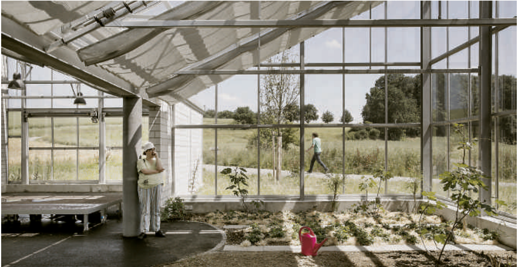
Das Glashaus im Park des Klotener Wohnheims Graswinkel. Im Hintergrund der öffentliche Spazierweg. Foto: Sophie Stieger
